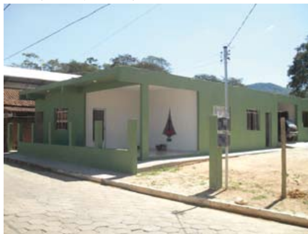
A casa pastoral já com a pintura.
