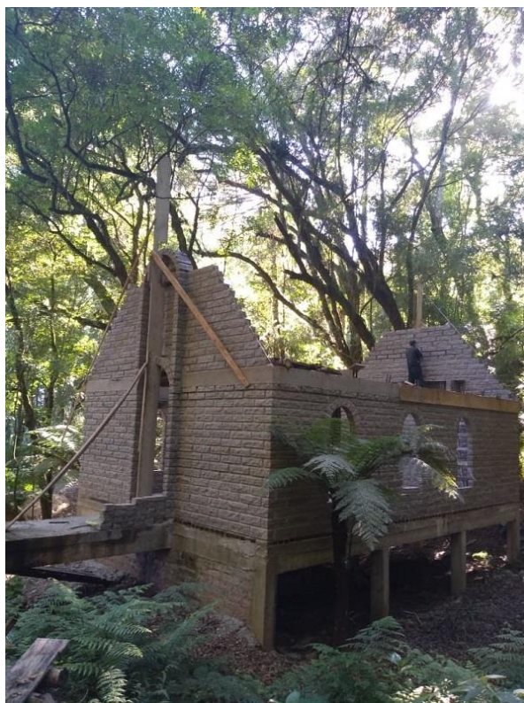
Templo em construção
