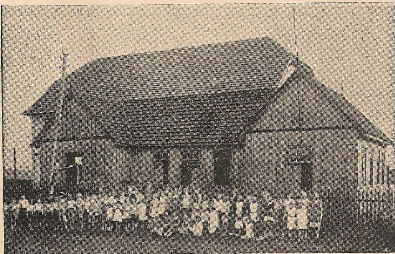
Grupo de alunos, tendo a professora Amália Lange ao centro, feito como despedida do prédio velho antes de ser demolido. Nos fundos aparece o telhado da nova construção, pronta para ser inaugurada. — (1931)
