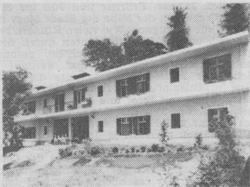
Das Heim der OASE in Freguesia d'Ó (Teilansicht)
