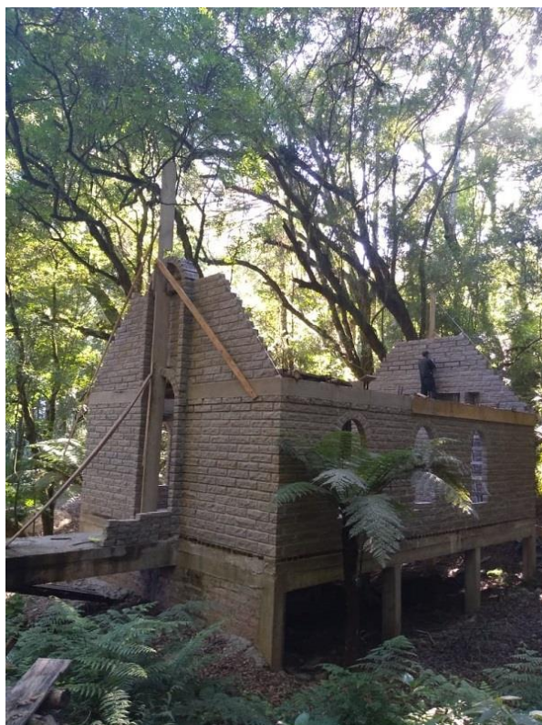
Templo em construção
